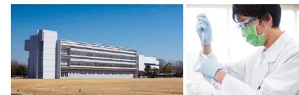
日本ジェネリック つくば第二工場
